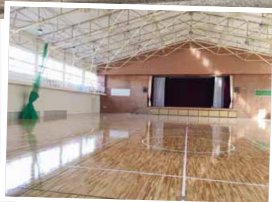
11月28日 台風被害から改修完了した 体育館（8回生撮影）
